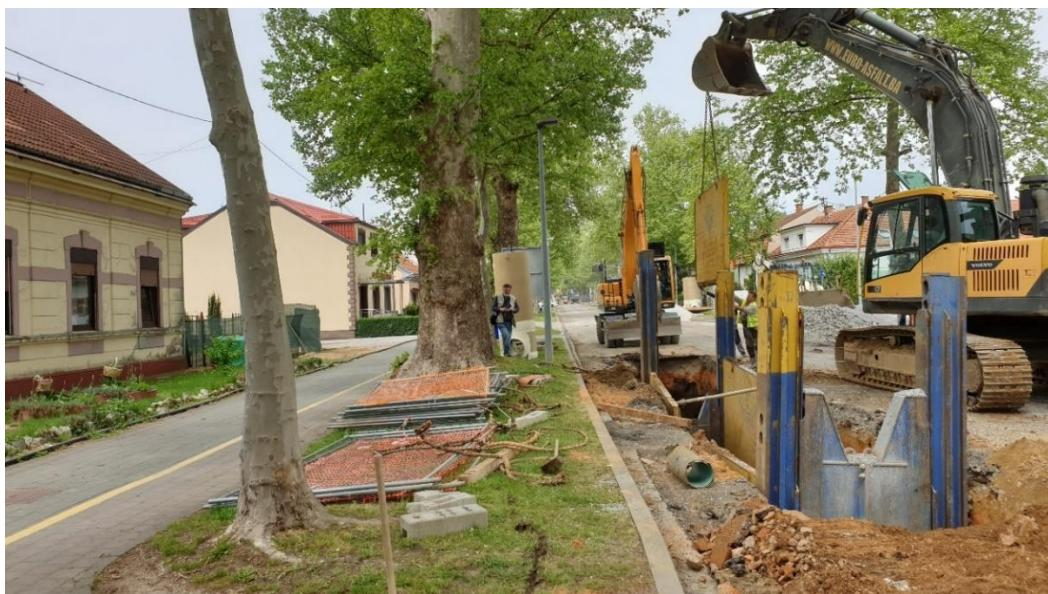
**Slika 1.** Građevinski iskopi sa ciljem obnove i unapređenje urbane infrastrukture provedeni su čitavom duljinom aleje sa obje strane obaju drvoreda te su iskopi često prolazili površinama unutar korijenske zone stabala. Osim samih iskopa, prilikom manipulacije opremom, alatima i strojevima također često dolazi do neželjenih posljedica za okolna stabla.
